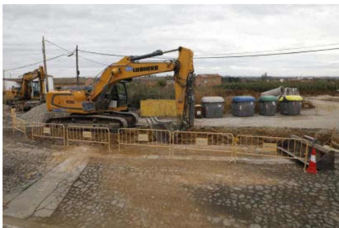
Obras. La mejora del alcantarillado de Llívia es una de las ejecutadas en los últimos años. - AMADO FORROLLA
